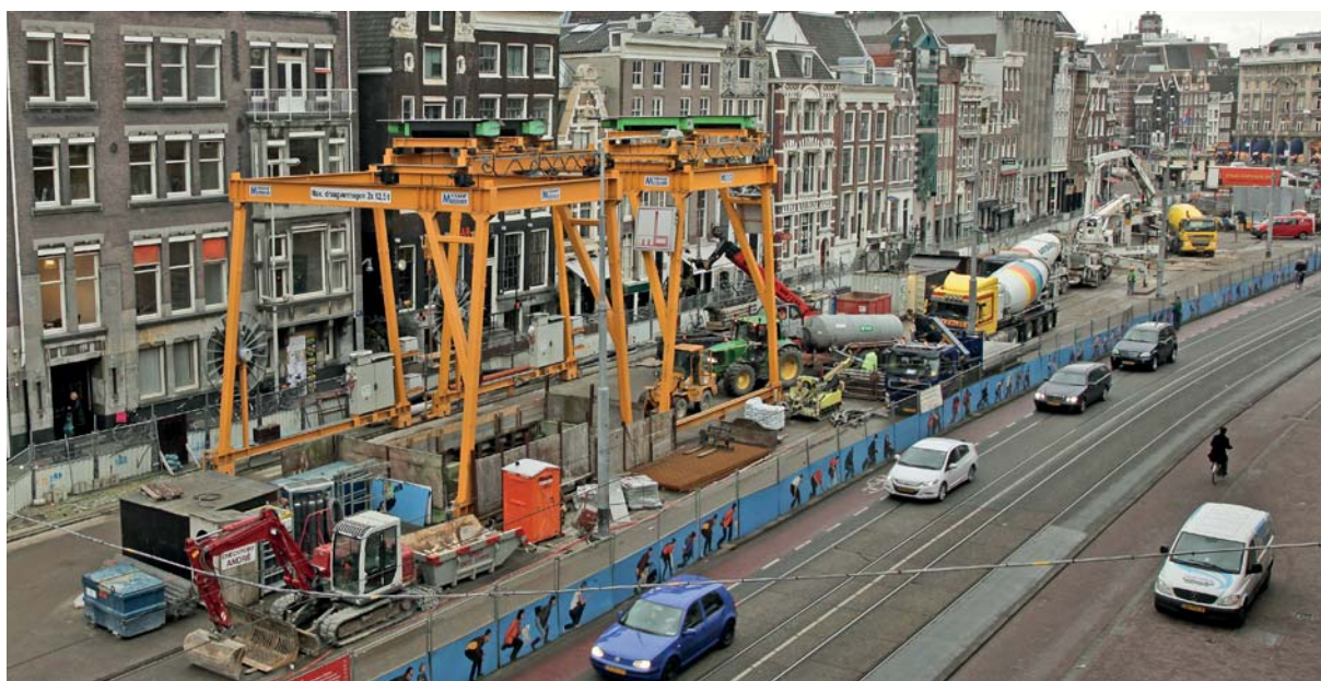
Afbeelding 2 Bouwput metrostation Rokin Noordzuidlijn (Fotograaf: Edwin van Eis, 4 februari 2011)
